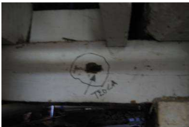
FIGURA 4.15 – Viga principal de suporte do vigamento secundário do segundo piso.
