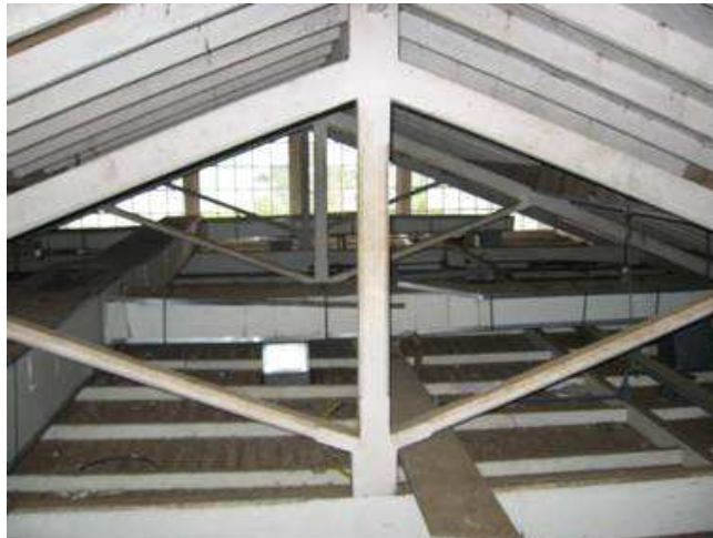
FIGURA 4.12 – Detalhe das tesouras da estrutura da cobertura.
