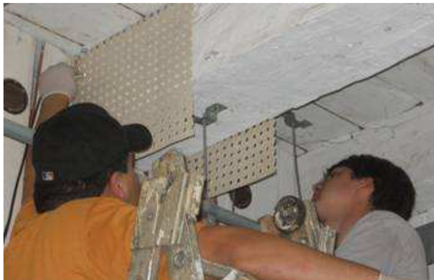
FIGURA 4.19 – Molde utilizado no mapeamento da viga.
