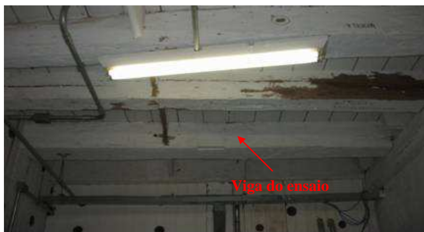
FIGURA 4.17 – Vigas secundárias (barrotes) de suporte do piso.
